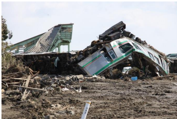
津波により破壊された電車と陸橋 ( JR 常磐線新地駅 )
