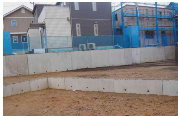
震災被害にあった家屋が解体された跡地。新たに宅地造成されたところが目立ってきた。
