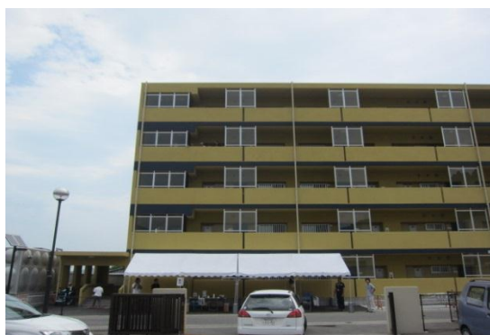
災害公営住宅(吉里吉里給食センター隣 34 戸)
