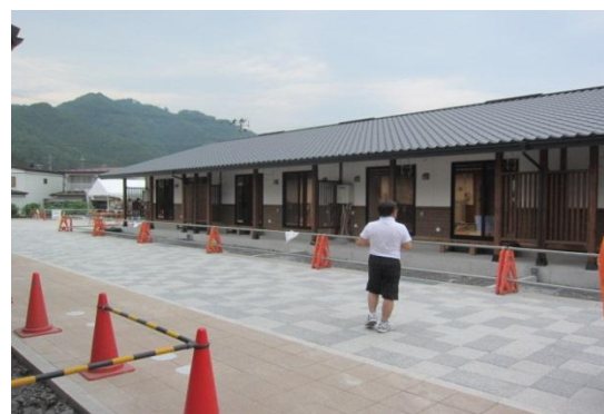
災害公営住宅(大ヶ口町営住宅跡地 70 戸)
