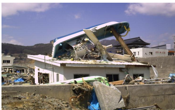
(2011 年 4 月 11 日) 津波で漁協の事務所の上に打ち上げられた漁船
