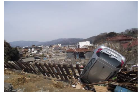
JR の線路も大きな被害を受け無残な状態となった
