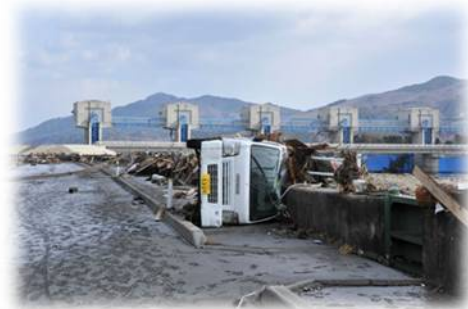
被災後の水門
