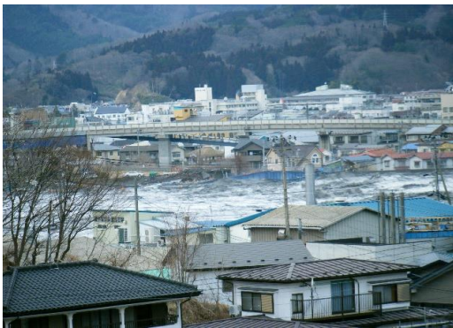
J R の鉄橋の北側半分が崩壊
