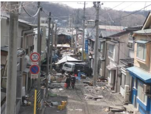
2011 年 3 月 12 日 愛宕小学校からみた被災状況
