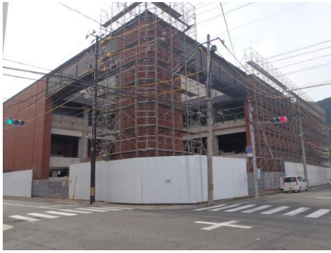
解体作業が進む市民文化会館
